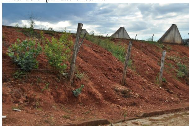
Figura 6. Talude exposto.
