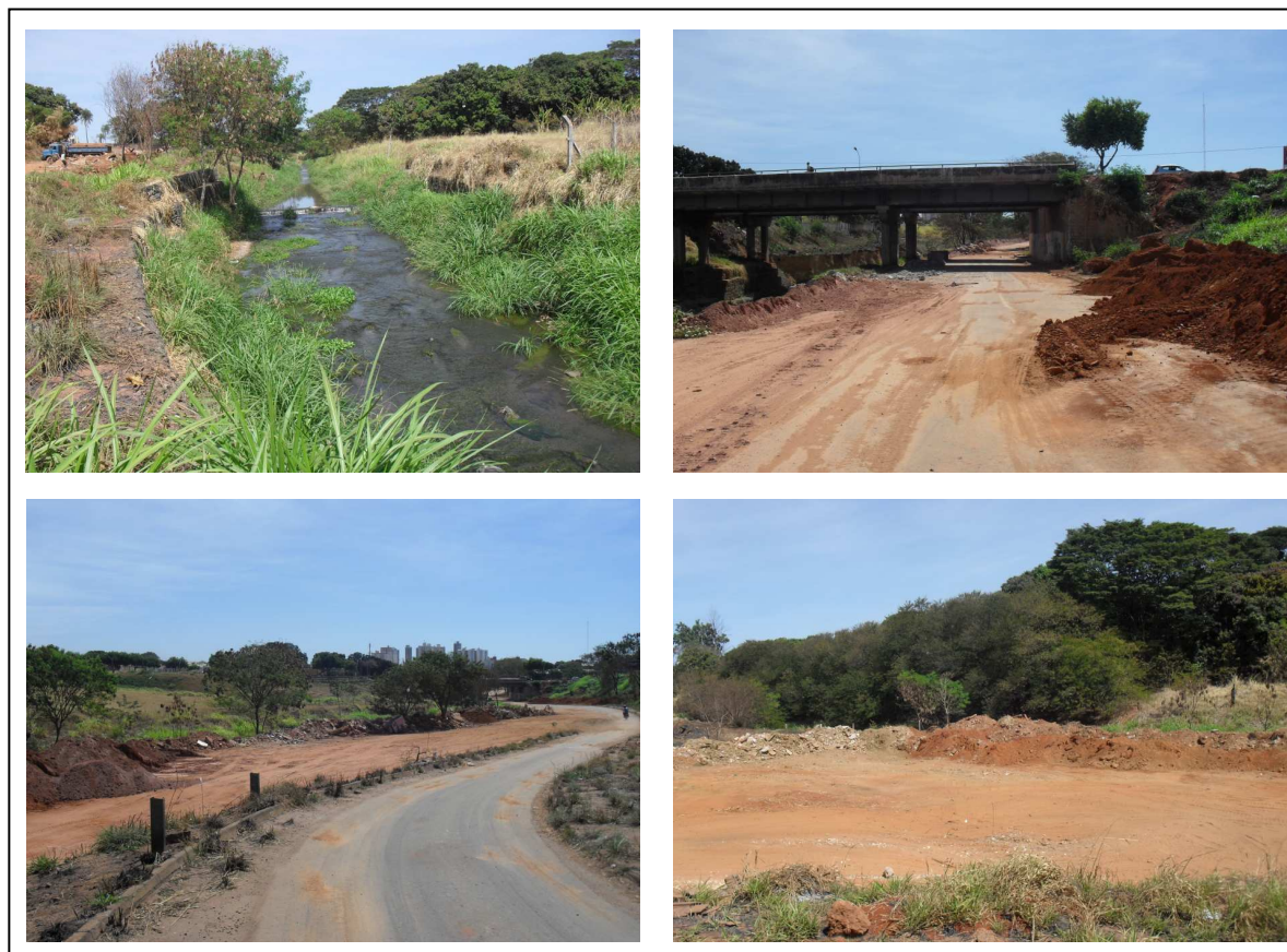
Figura 8 - Lançamento clandestino de entulho ao longo do Córrego Cascavel.
