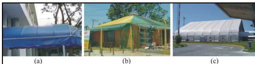
Figura 4. Toldos em PVC colorido são utilizados mais freqüentemente em pequenas coberturas, como em (a) e (b), mas também foram encontrados em estruturas de maior porte, como galpões de campanha (c).
