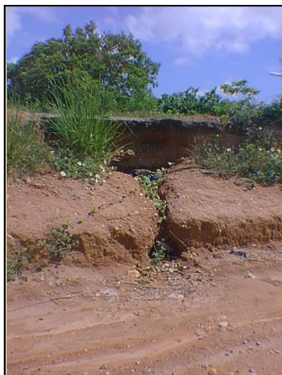
Figura 7 – Sulco de erosão pluvial, RN 304 médio Curso do rio Pitimbu.
