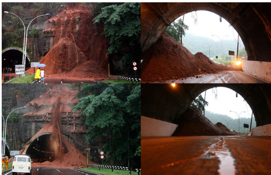
Figura 1. Deslizamentos de toneladas de terra no Túnel Rebouças causados por precipitações intensas no centro urbano do Rio de Janeiro no do dia 24 de outubro de 2007. (FONTE: http://oglobo.globo.com/rio/transito/mat/2007/10/24/326882635.asp ).
