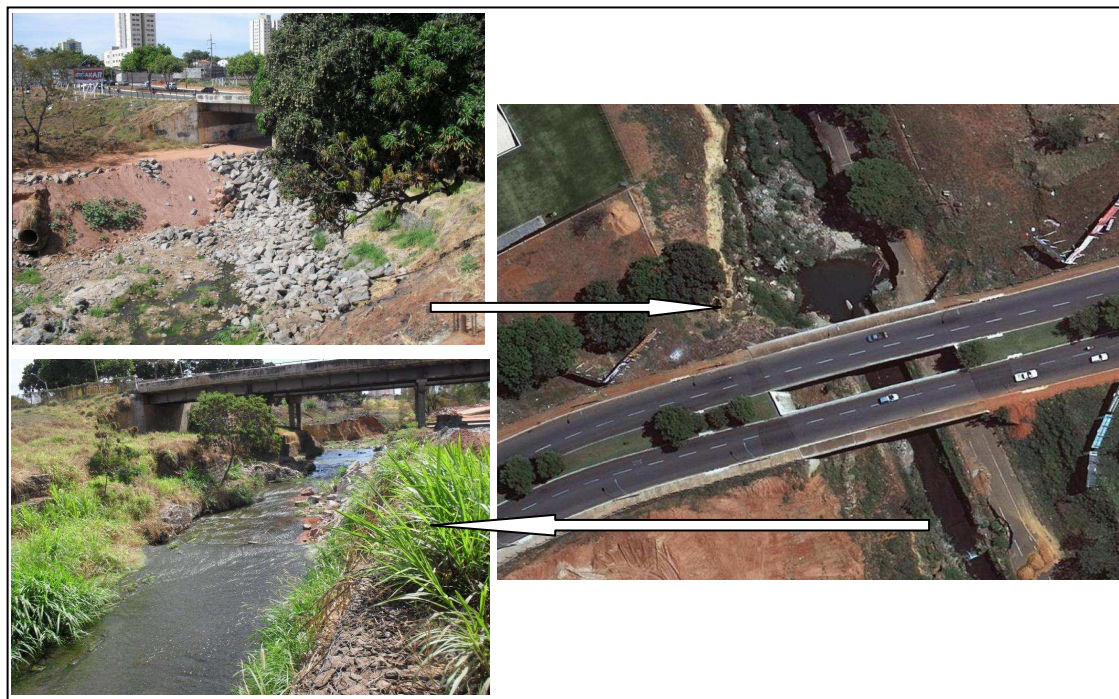
Figura 6 - Alguns pontos de degradação ao longo do córrego próximo a Avenida T-63.
