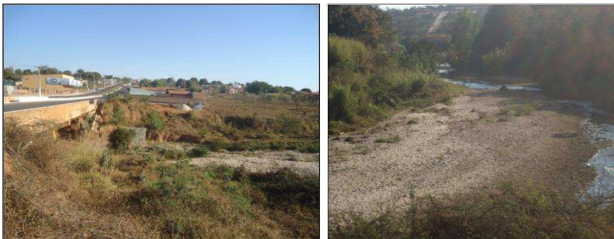
Foto B e C – Caracterização do processo de ocupação antrópica – Erosão e assoreamento das margens do Ribeirão Santo Antônio em área urbana (Setor Veiga Jardim).
