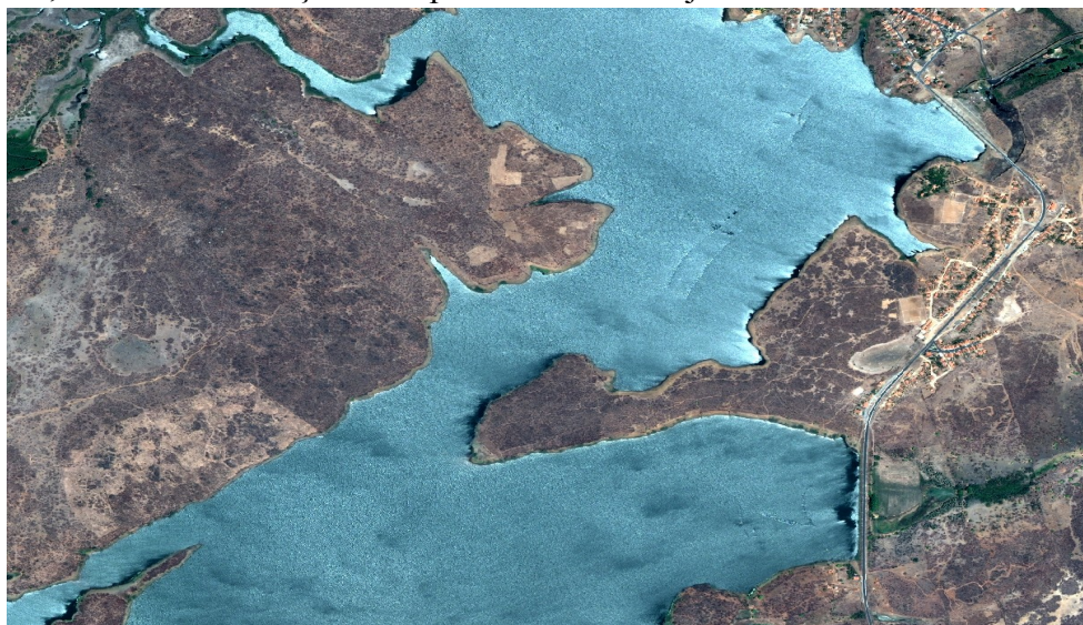
Figura 2 Detalhe da barragem do Açude Ayres de Souza – imagem Quickbird.
