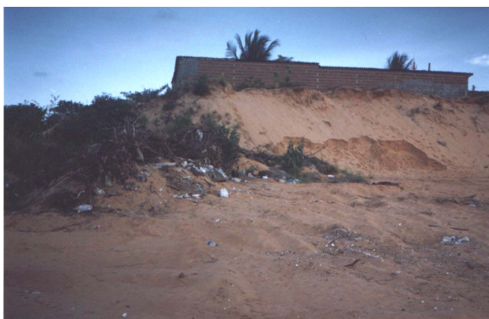
Figura 6: Construção de residência em cima de uma Duna na localidade de Nova Parnamirim provocando danos ambientais (Fonte: Aquanor, 2003).
