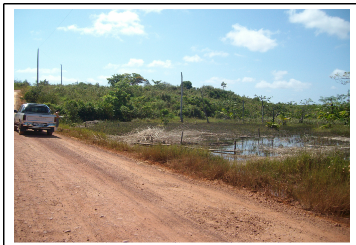
Figura 4. Exemplo de um cruzamento estrada sobre igarapé, com manilha de concreto como estrutura de transposição.
