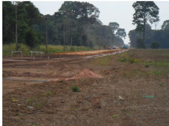
Figura 4B- Trecho da PA-443 em obras e as implicações na paisagem, Município de Belterra (PA).
