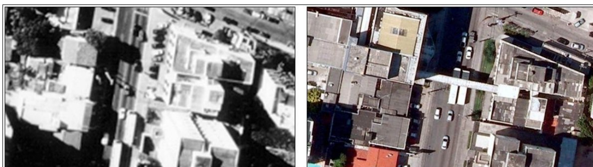
Figura 5 – Passarela que interliga duas unidades do Hospital Prontolinda, Olinda-PE. Fonte: CONDEPE/FIDEM, 1997 e Google Earth, 2010, respectivamente.
