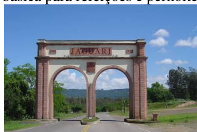
Figura 1 – Pórtico de entrada ao município.
