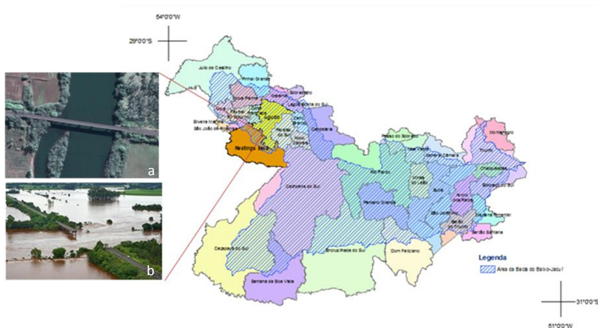
Figura1(a): Ponte RSC-287 antes da queda. Figura 1(b): Ponte RSC-287 após a queda e enchente.
